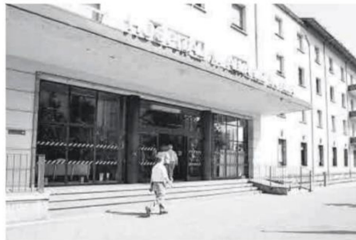
Acceso al antiguo hospital de Murias antes de su cierre.
